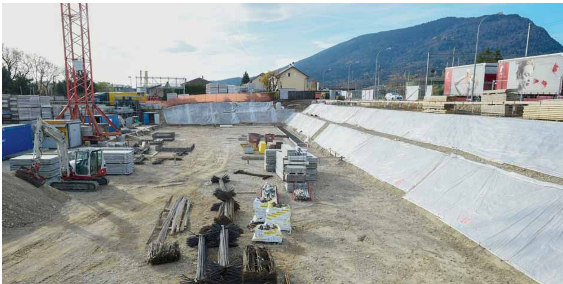
Le chantier avance à grands pas. L'entrée en jouissance du nouveau bâtiment est prévue pour la mi-novembre 2018. CHRISTIAN GALLEY
